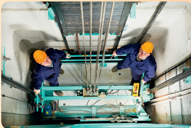
pohled do výtahové šachty
